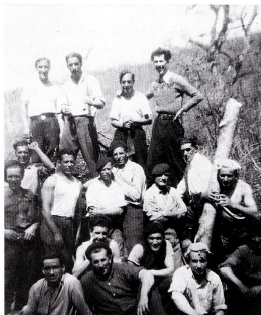
Le chantier de Boissezon en 1943. Fernando VILLAJOS tient une bûche.
