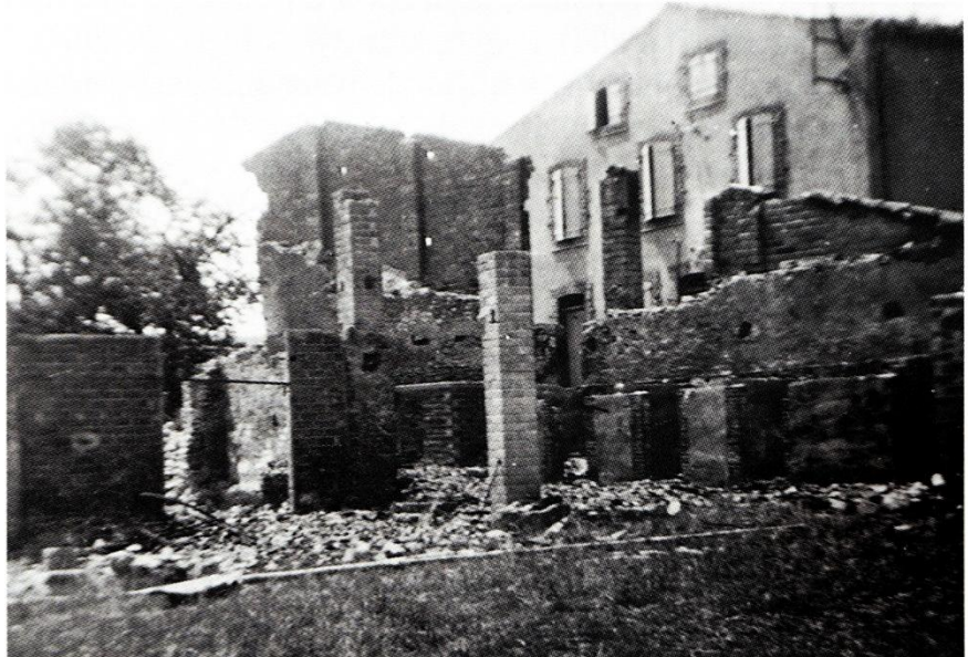
Les ruines des bâtiments agricoles incendiés le 29 juin 1944.
