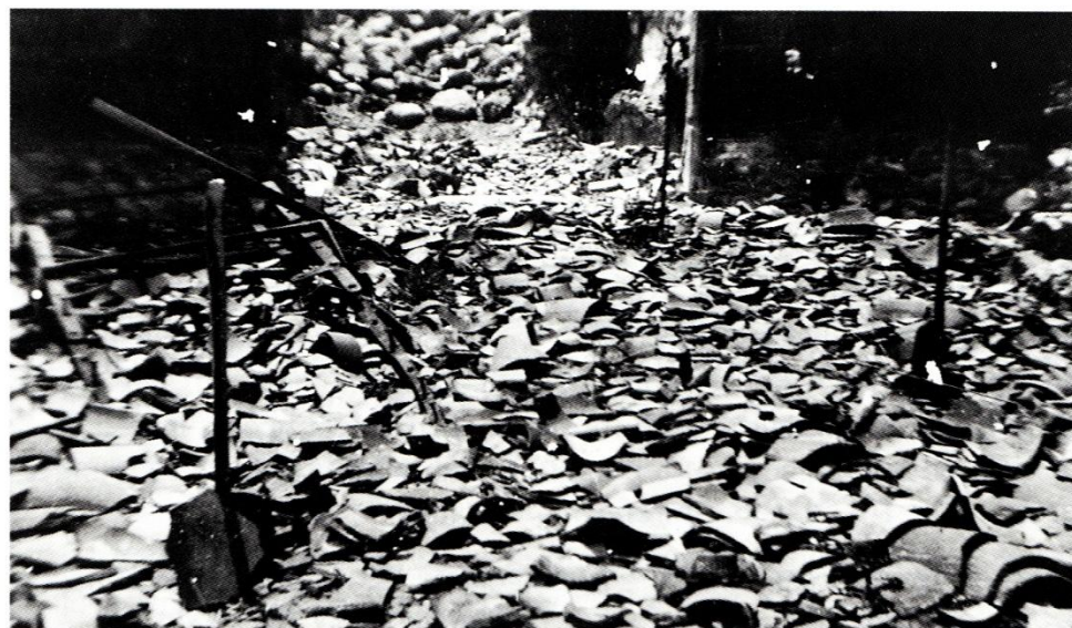
Sous ces tuiles et poutres furent retrouvés les trois corps.
