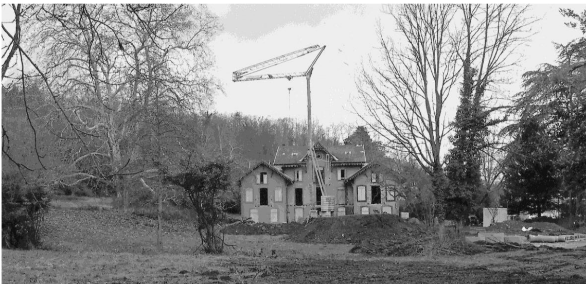
Pendant les travaux en février 2011
